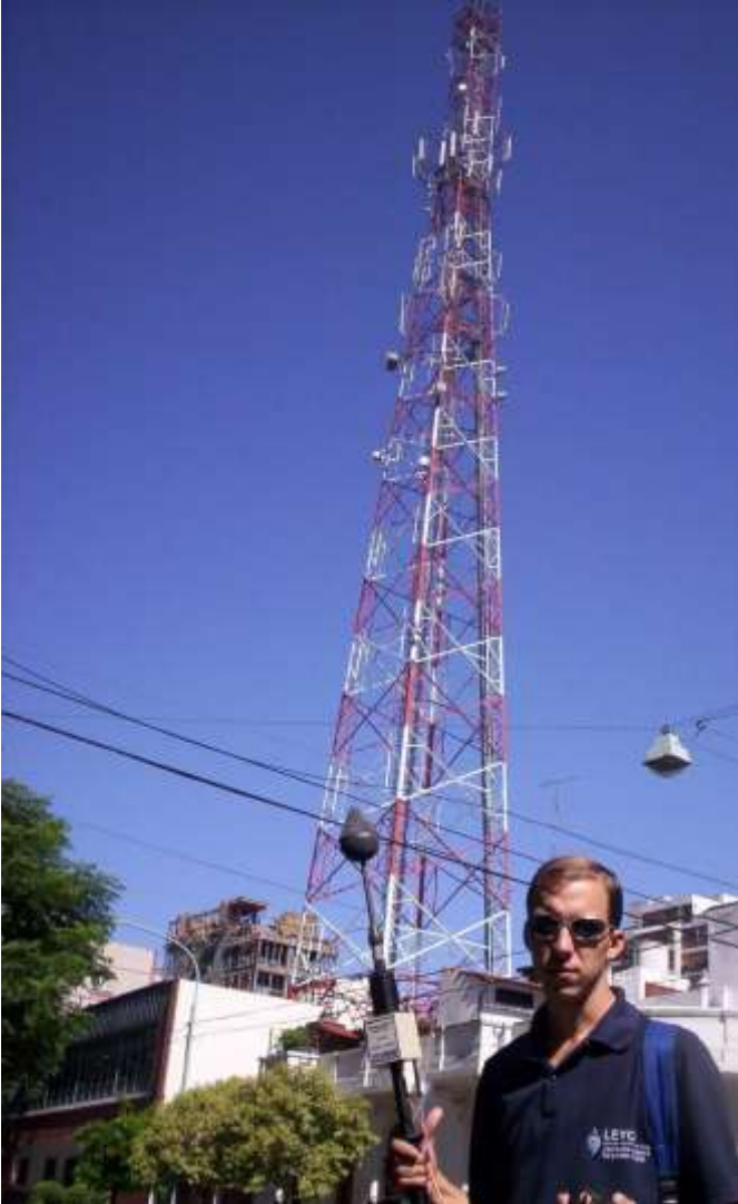
Foto I: Antenas montadas en Torre "Autosoportada"
