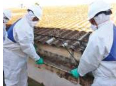
RETIRO DE ASBESTO
