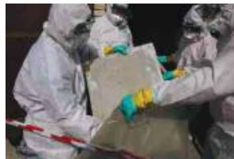
RETIRO DE ASBESTO
